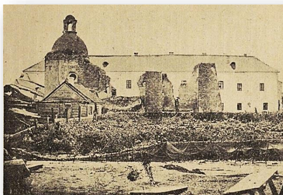
Зруйнована церква Луцького братства. 19 століття.
